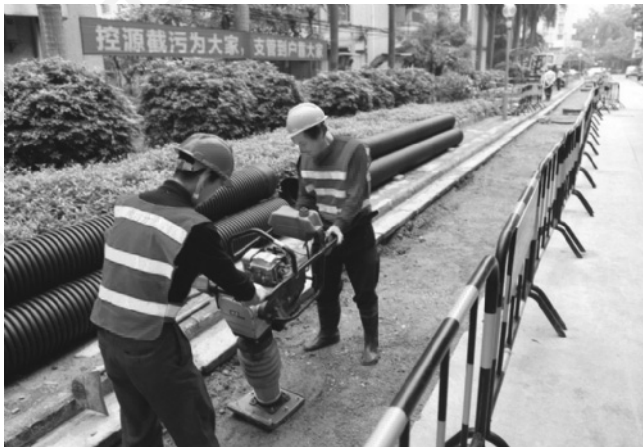
负责雨污分流的 工程人员正在施 工中
