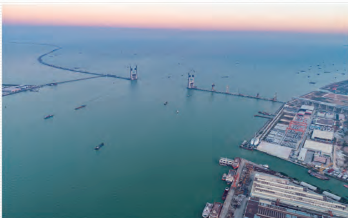
至2020年年底，深中通道中山大桥东、西主塔已完成102米，陆域段40米箱梁全部完成预制，已架设498片。黄春华摄于2020年12月28日
