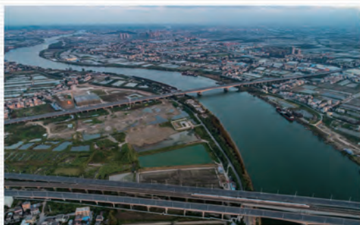
广珠城际跨鸡鸦水道大桥。黄春华 摄
