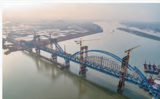
2021年2月，位于黄圃镇的南沙港铁路跨洪奇沥水道大桥第二拱吊升合龙，其跨距在亚洲同类桥梁中位居第一。黄春华 摄
