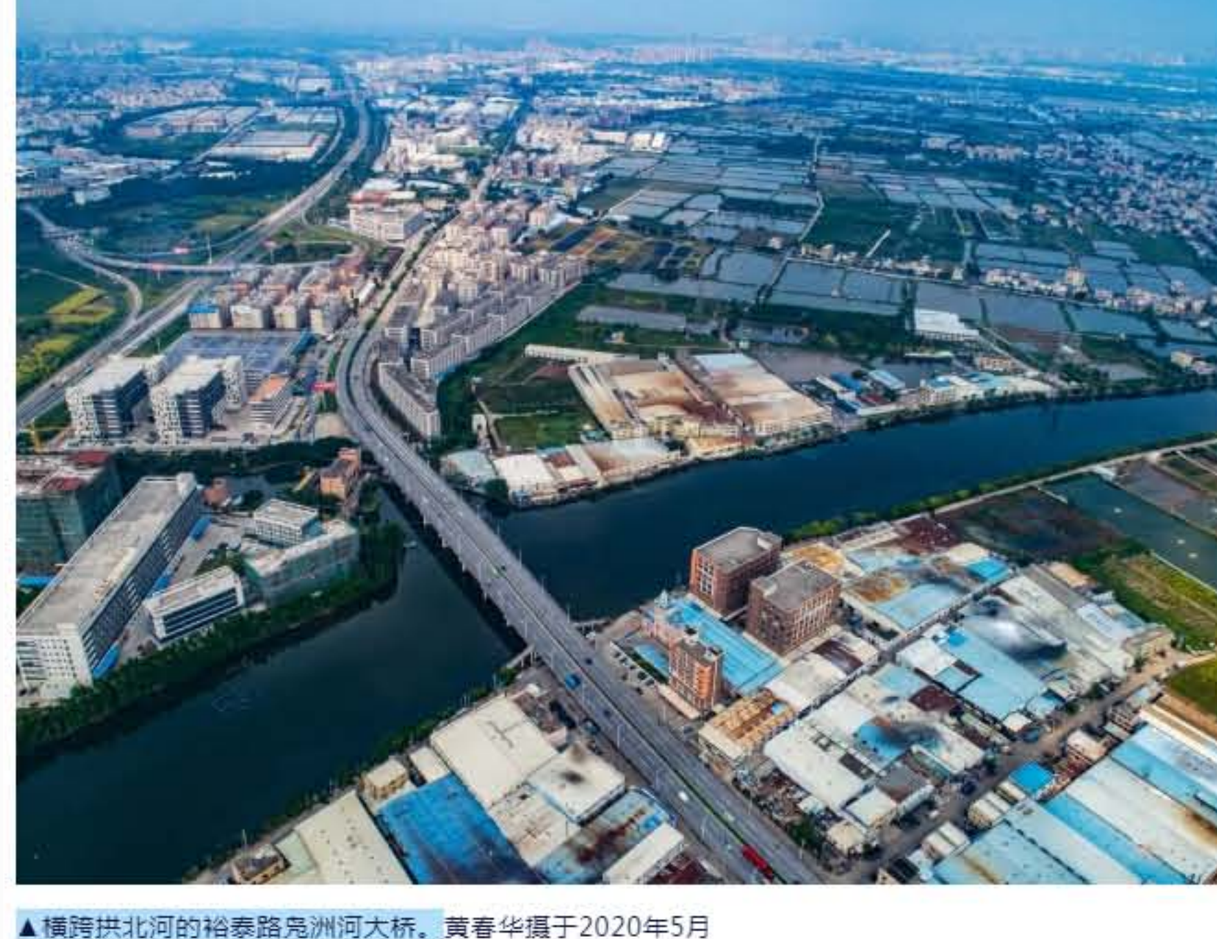
▲横栏拱北河的裕泰路免洲河大桥，黄春华摄于2020年5月
