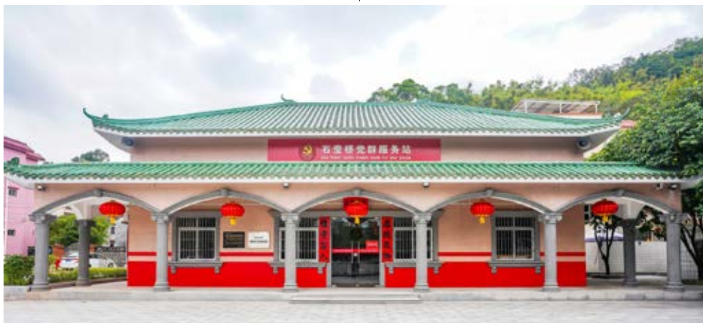
中山县行政督导处成立遗址新建筑正面（黄春华摄于2023年2月）
