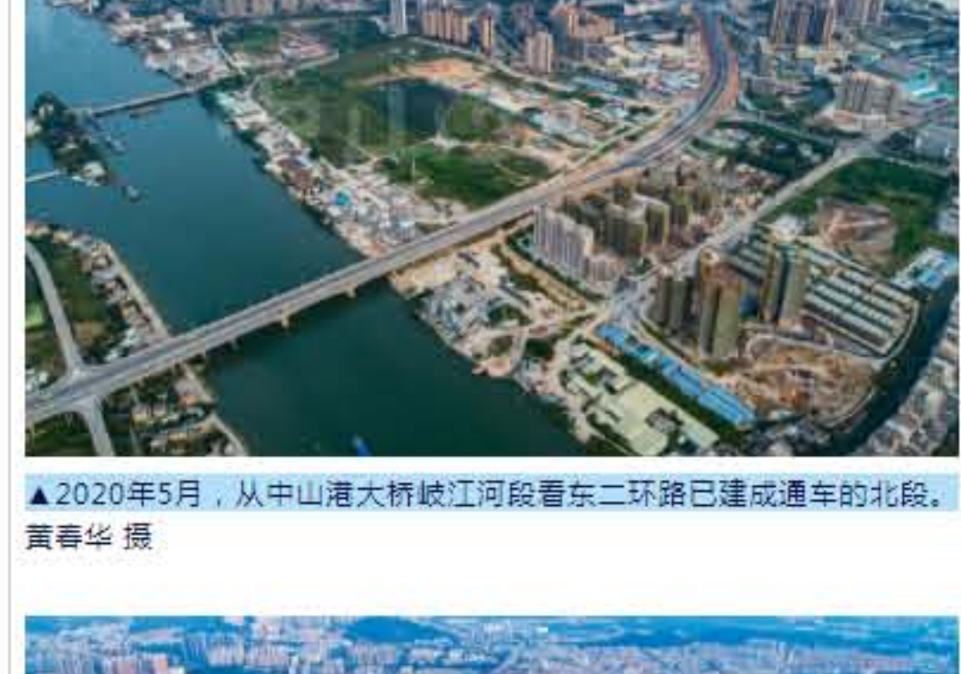
▲2020年5月，从中山港大桥跨江河视角看东二环路已建成通车的北段。黄春华 摄
