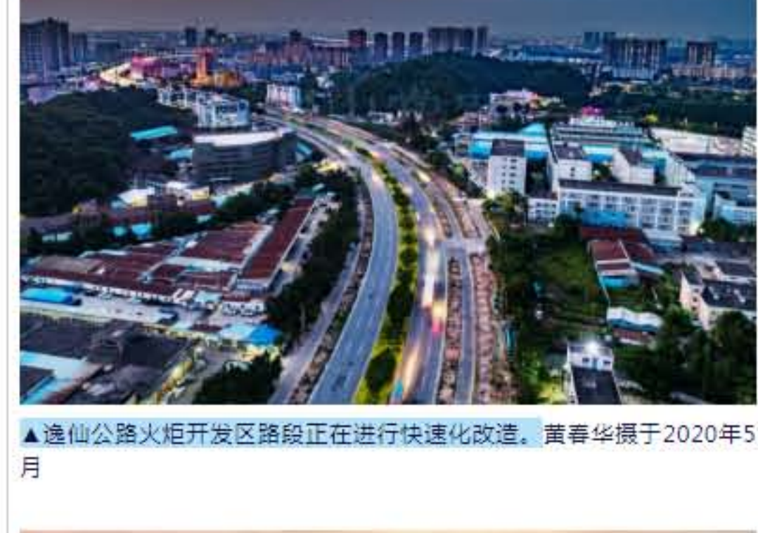
▲逸仙公路火炬开发区路段正在进行快速化改造。黄春华摄于2020年5月
