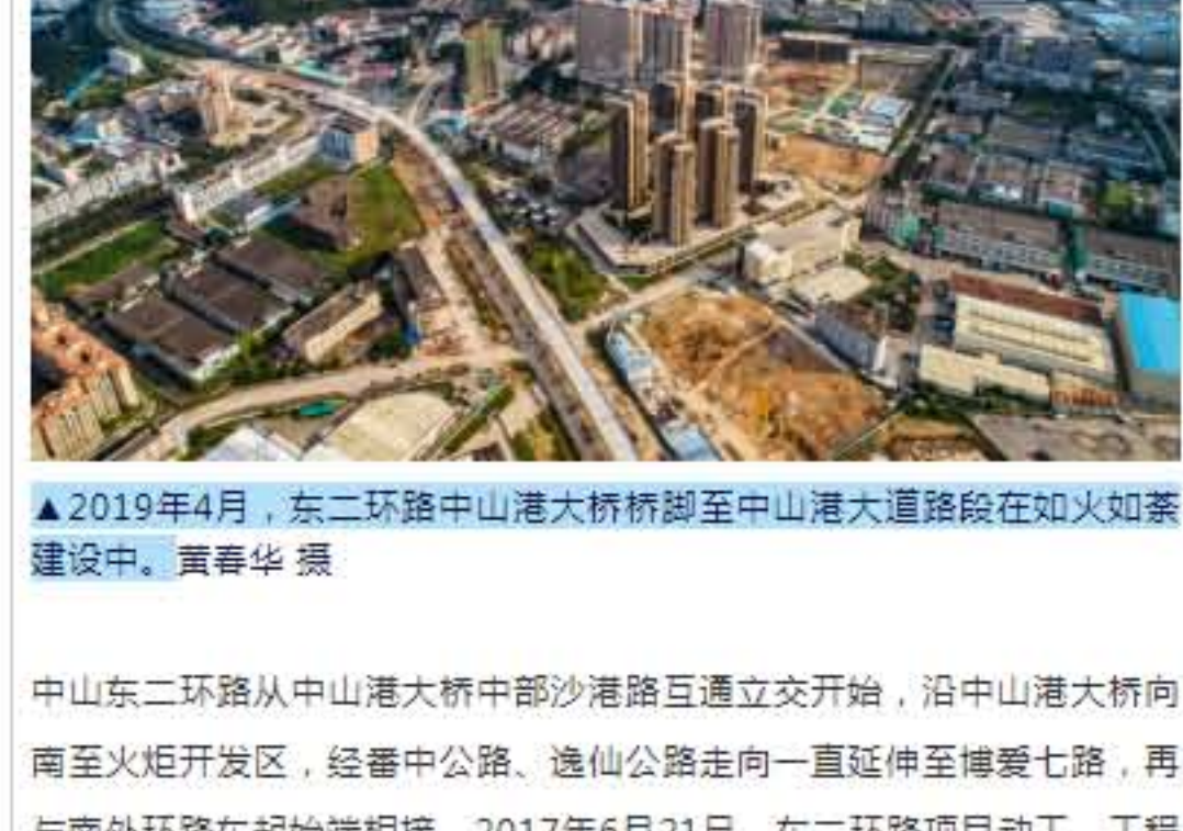
▲2019年4月，东二环路中山港大桥桥脚至中山港大道路段在如火如荼建设中。黄春华 摄
