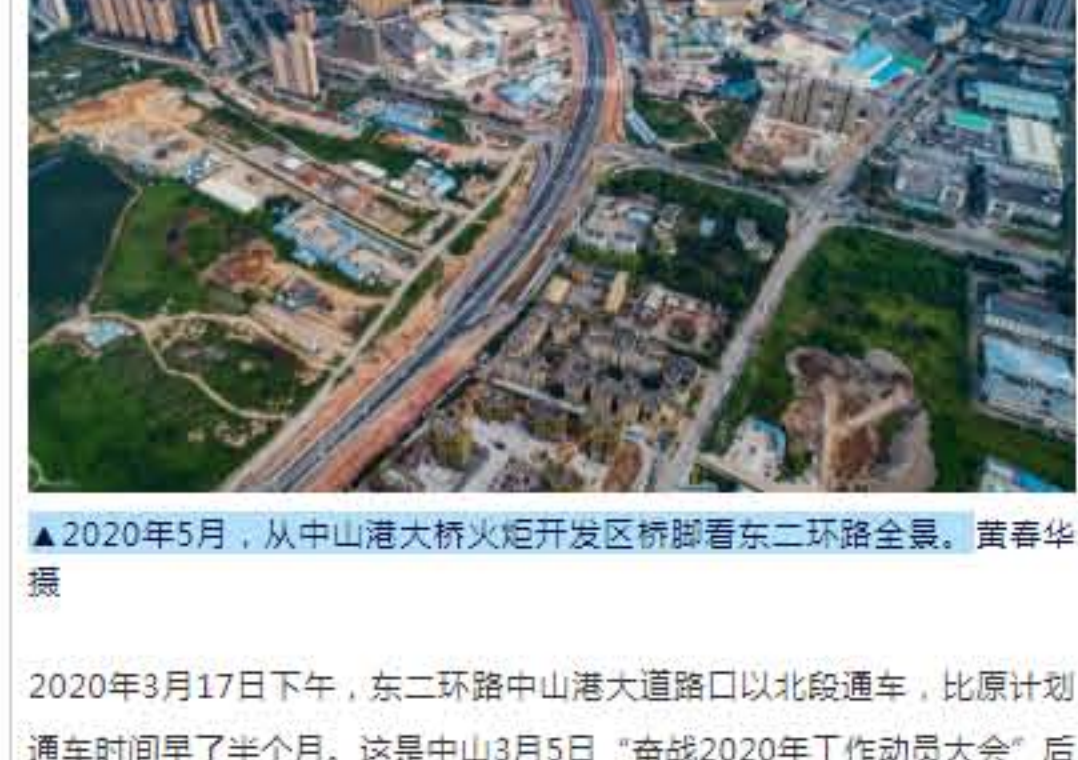
▲2020年5月，从中山港大桥火炬开发区桥脚看东二环路全景。黄春华 摄
