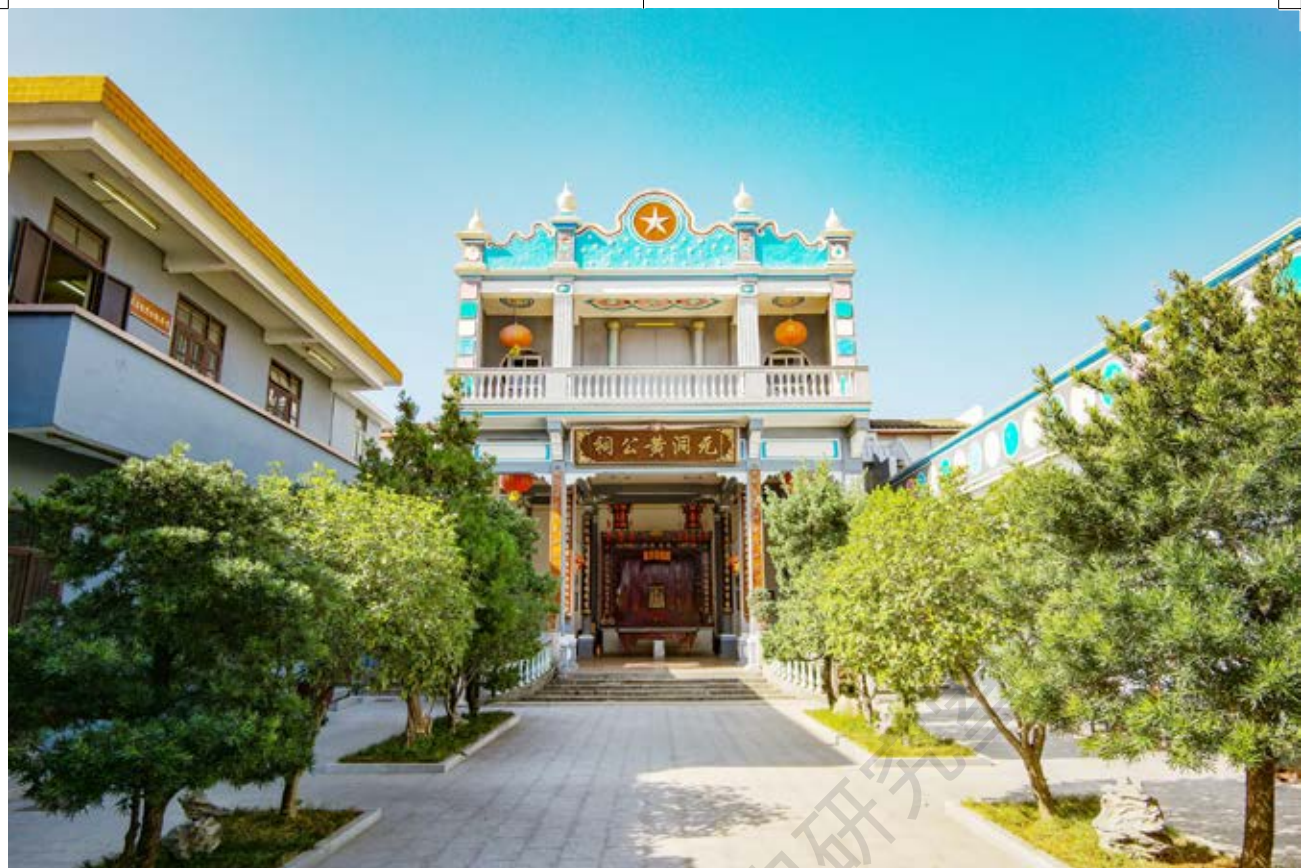
肇园——黄石生中队队部旧址内元洞黄公祠全景（黄春华摄于2021年11月）
