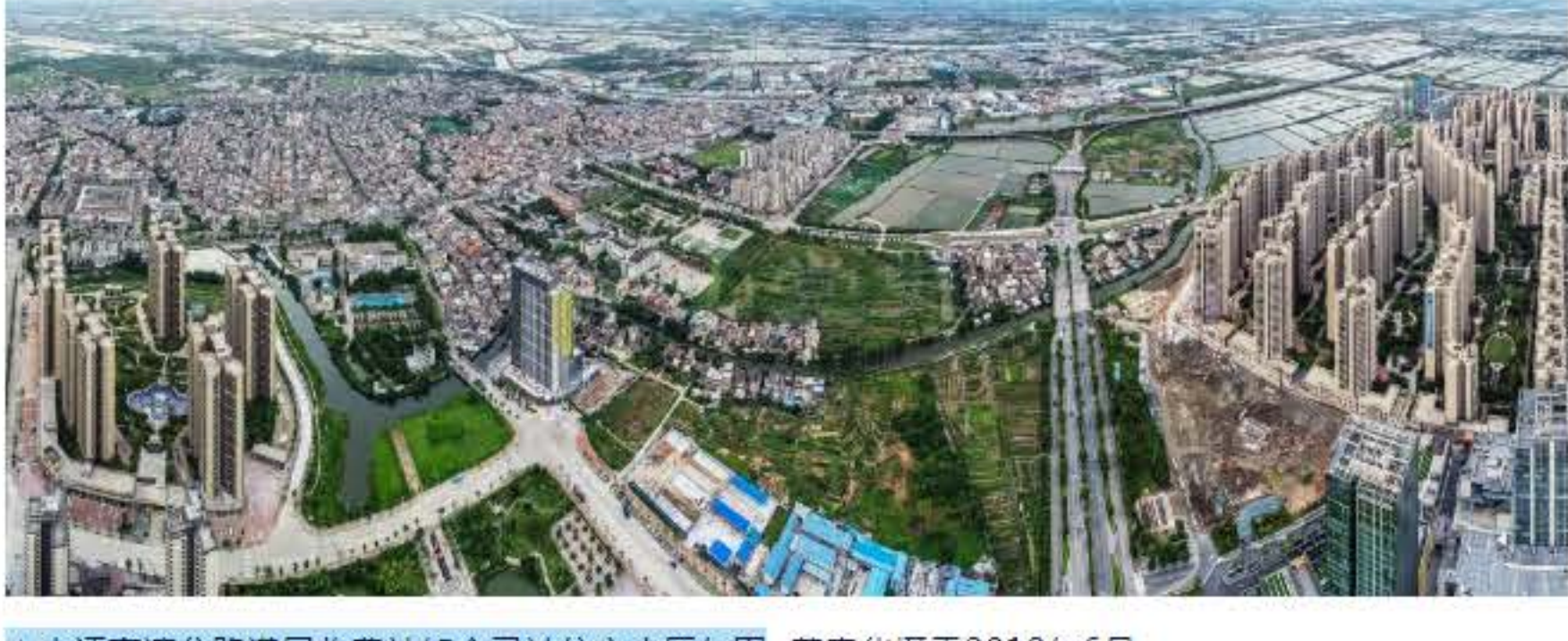
▲中江高速公路港口收费站如今已被住宅小区包围 黄春华摄于2019年6月
