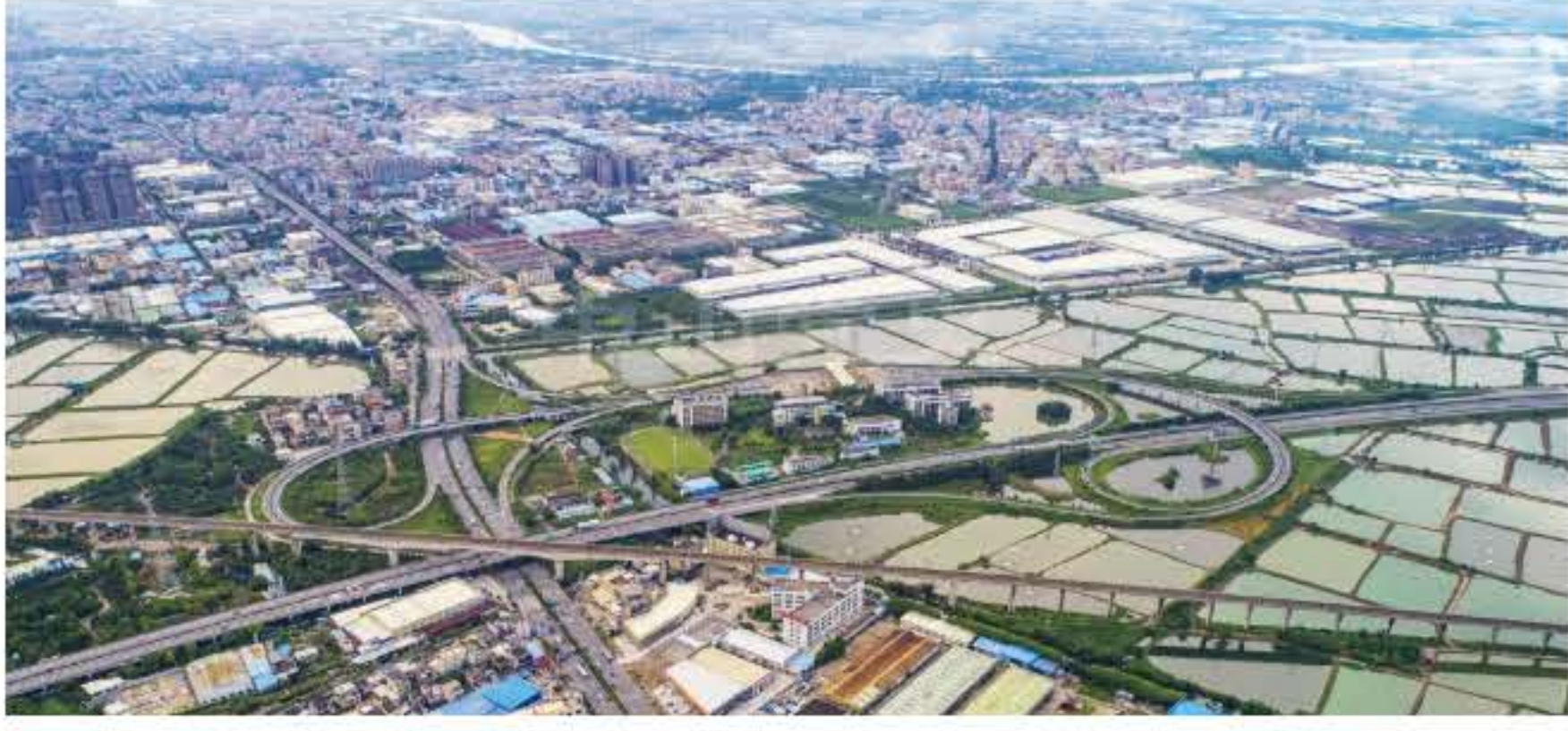
▲位于东升镇的珠三角环线高速公路（中江高速公路）与105国道交汇立交及东升收费站 黄春华摄于2017年10月
