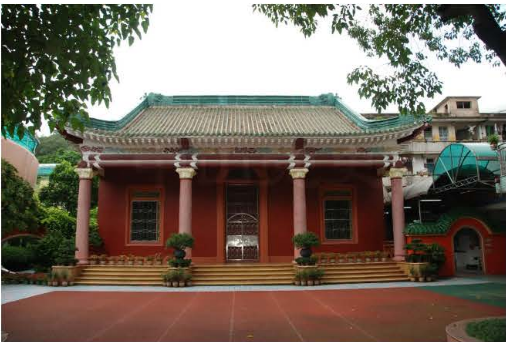
▲中共中山县工作委员会成立旧址（位于石岐区莲兴社区莲塘路中山市机关第一幼儿园内）
